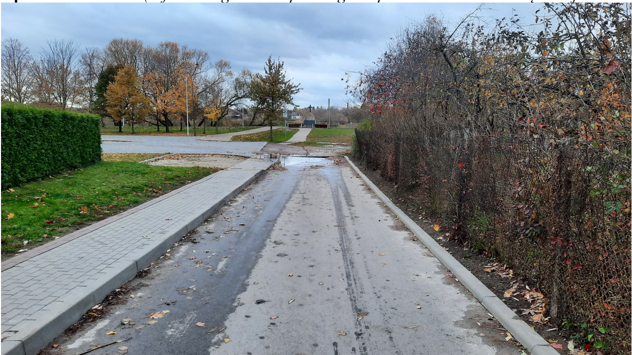
5 pav. Esamas kelias (aukštas šaligatvio kelkraštis, siauras asfaltuotas kelias skirtas vienpusiui judėjimui)
