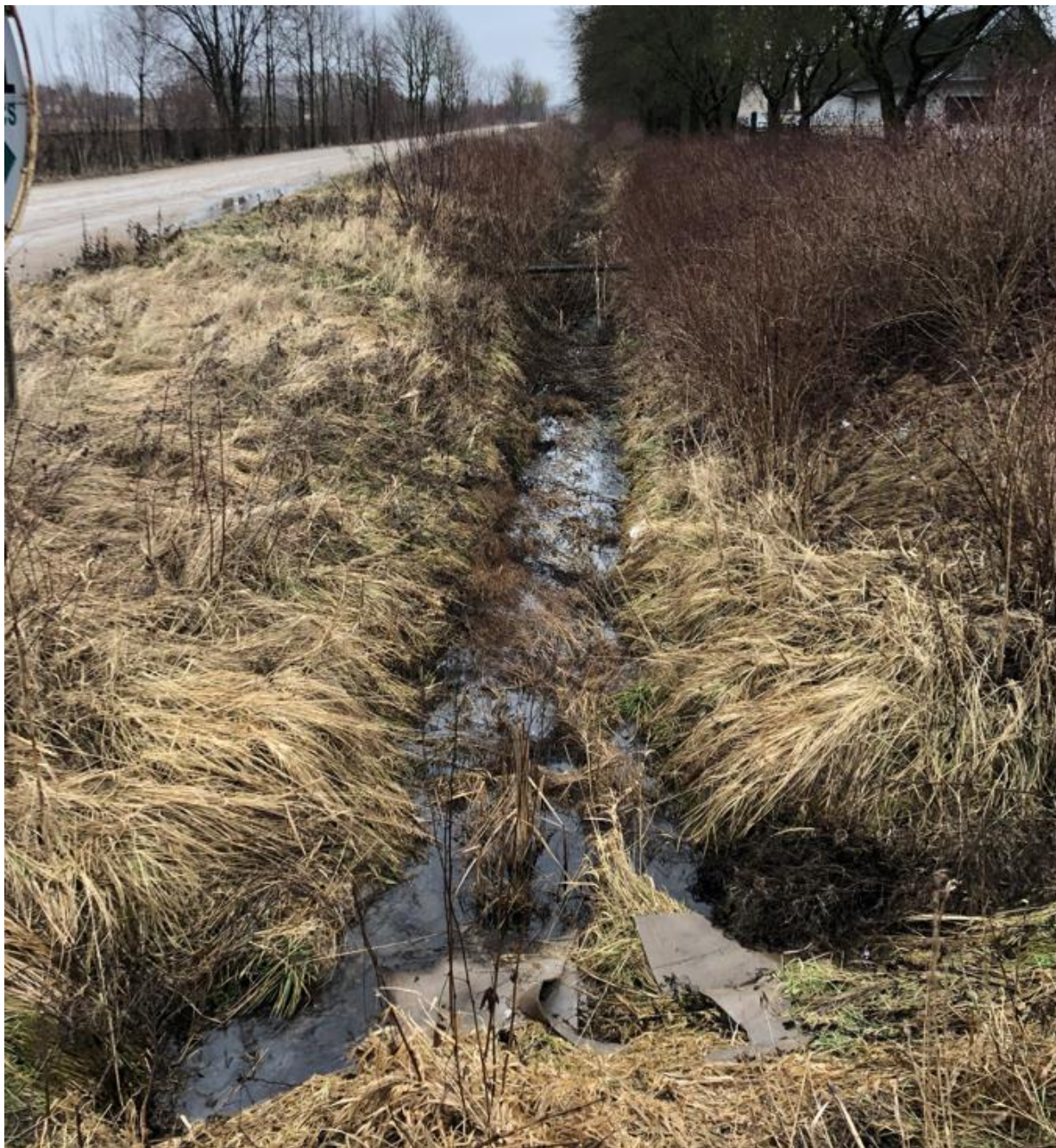
1 pav. Esamos gatvės būklės fotofiksacija
