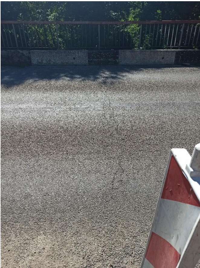
4 pav. Važiuojamoji kelio danga ties deformaciniais pjūviais supleišėjus, ties pereinamosiomis plokštėmis pasėdusi;
