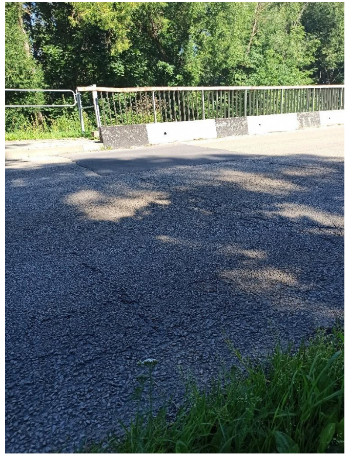
4 pav. Važiuojamoji kelio danga ties deformaciniais pjūviais supleišėjus, ties pereinamosiomis plokštėmis pasėdusi;
