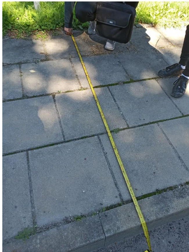
6 pav. Esamas pėsčiųjų-dviračių takas 2,0 m pločio yra per siauras
