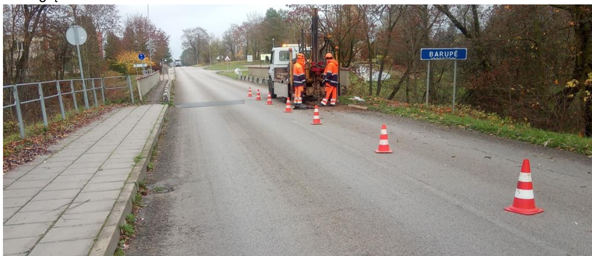
1 pav. Lauko darbai gręžimo įrenginiu WAMET-H20S-KU
