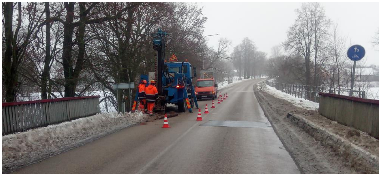
2 pav. Lauko darbai gręžimo įrenginiu KB20
