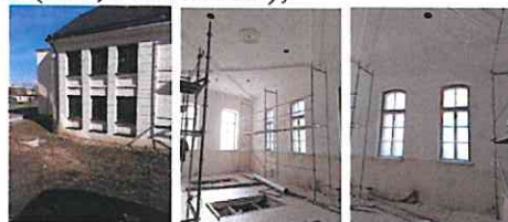
36 pav. Kėdainių sinagogos sutvarkymo darbai
