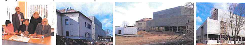
33 pav. Kėdainių kultūros centro pastato rekonstrukcijos aptarimas (1) ir darbų eiga (2, 3, 4)
