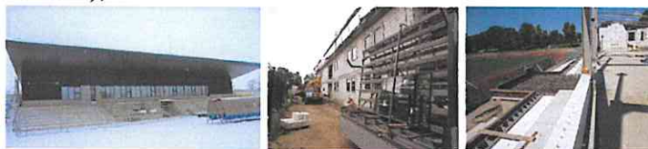
30 pav. Stadiono aptarnavimo ir buities pastato su dengtomis tribūnomis įrengimo darbai
