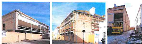
31 pav. Kėdainių šviesiosios gimnazijos pastato rekonstrukcijos darbai
