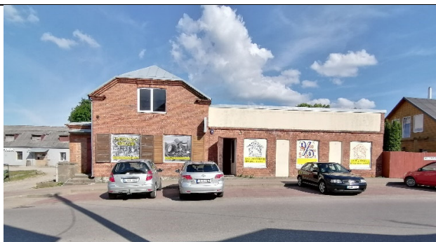
Šiaurės vakarų fasadas
