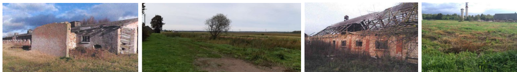
27 pav. Objektas Okainių k. (prieš ir po), Objektas Vilainių k. (prieš ir po)
