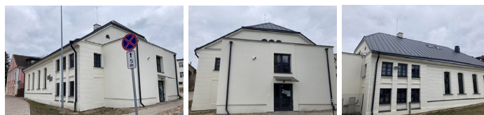
41 pav. Kėdainių sinagogos sutvarkymo darbai
